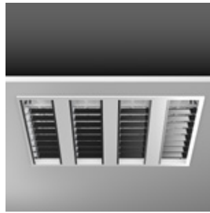
Altanlage mit Spiegelrasterleuchte
